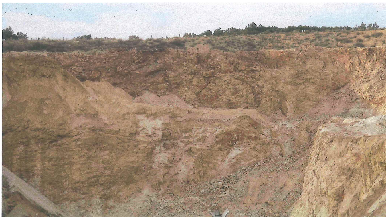
Vue rapprochée du front de taille sud
